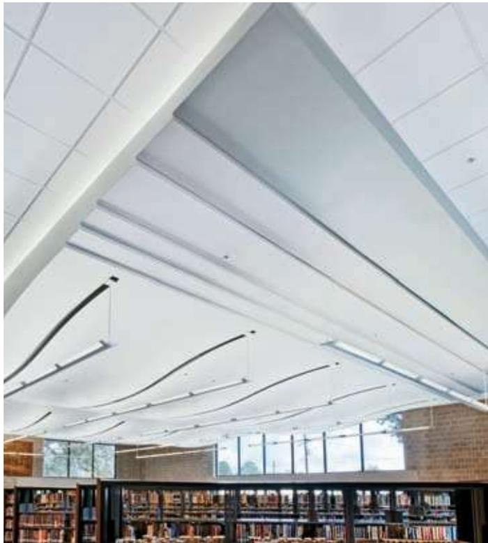
Sistema de suspensión prediseñado para paneles de yeso planos y curvos; es tres veces más rápido de instalar que el sistema tradicional.
